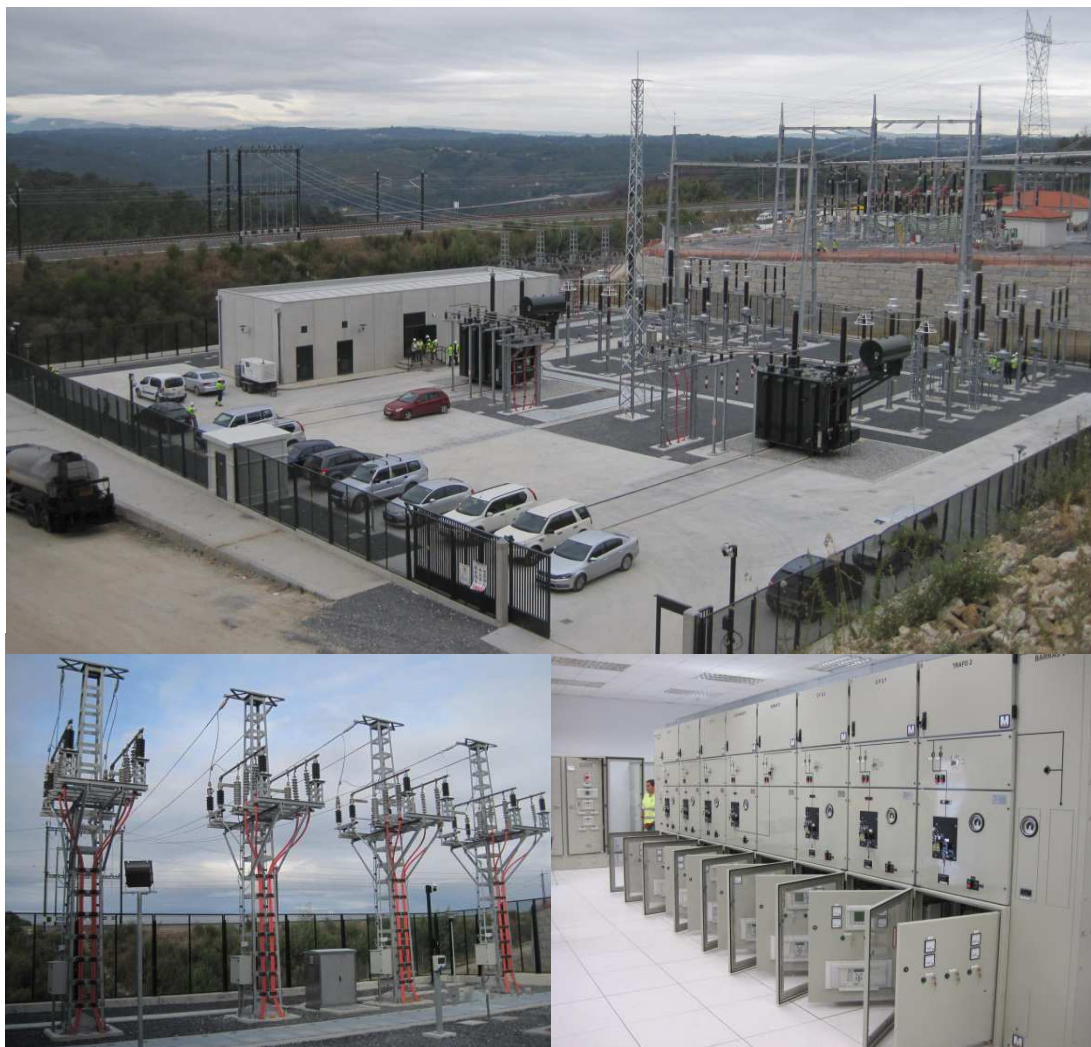
Obrázek 4: Napájecí stanice 2x25kV pro úsek tratě Orense-Santiago (SEMI Group for Adif)
