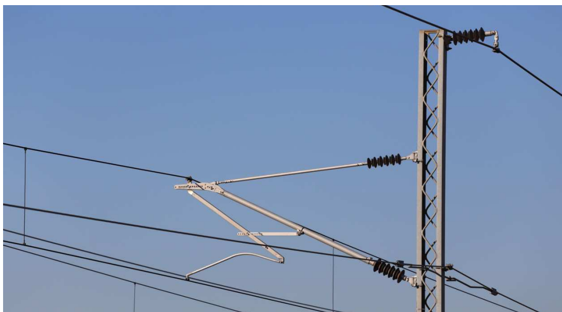
Obrázek 6: Itálie – použití konzoly typu „vně“ na VRT Řím – Neapol
