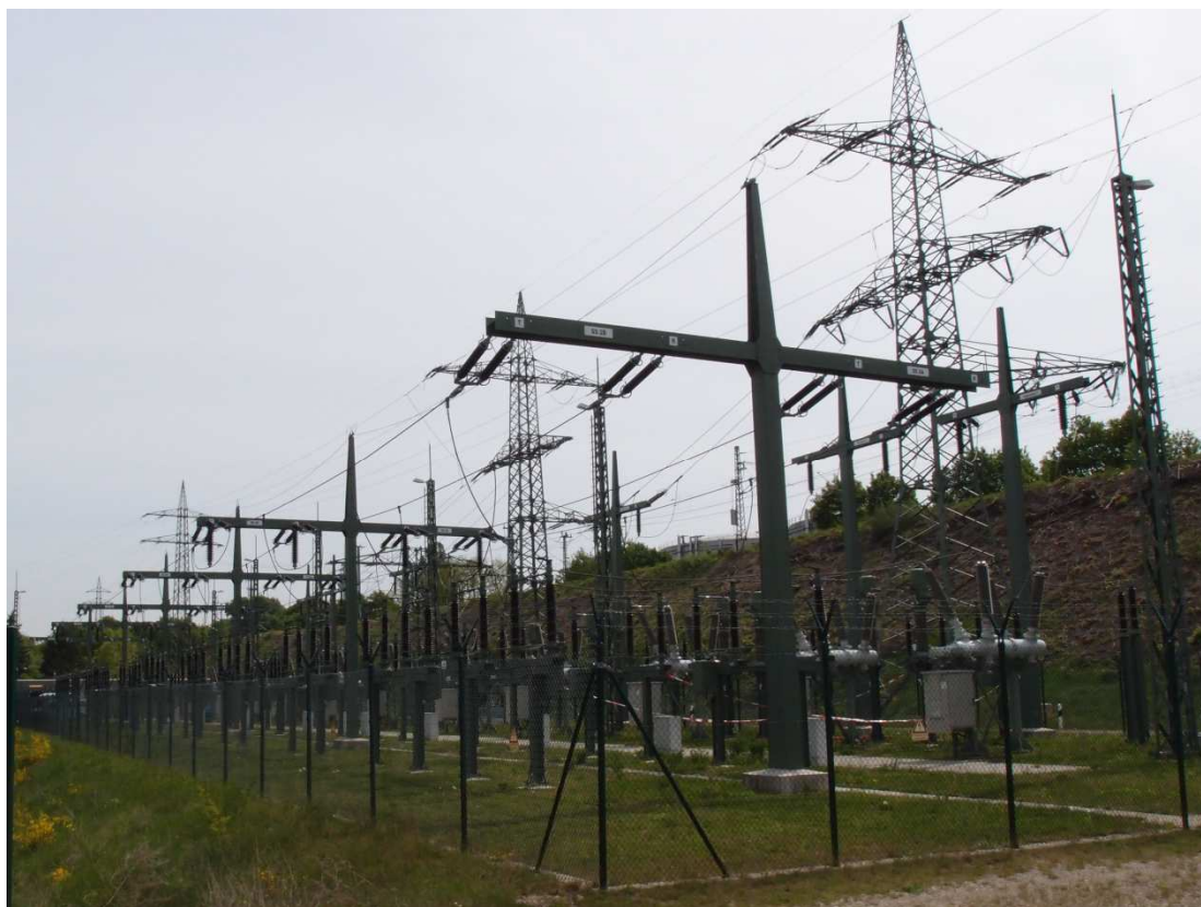
Obrázek 1: Napájecí stanice Norimberk – rozvodna 110 kV 16,7 Hz
