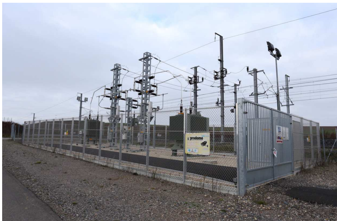
Obrázek 3: LGV Strasbourg – Paris; autotransformátorová stanice 2x25 kV 50 Hz
