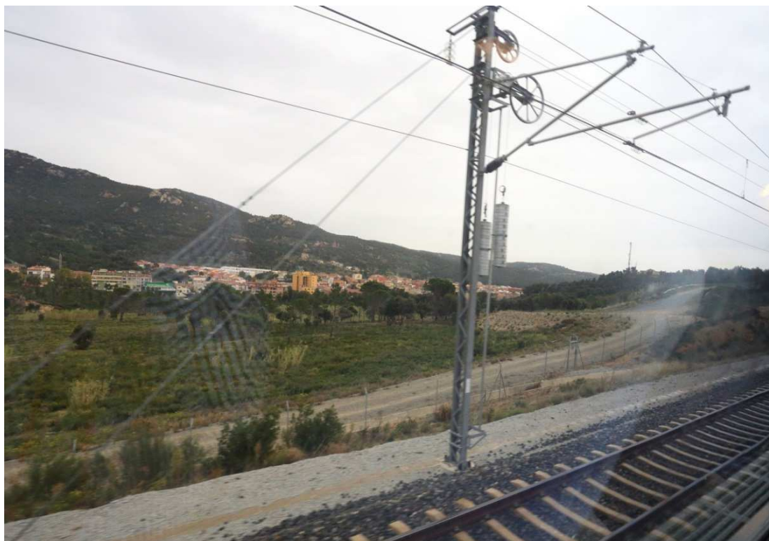
Obrázek 7: Španělsko –kotvení TV na LAV Perpignan – Figueras
