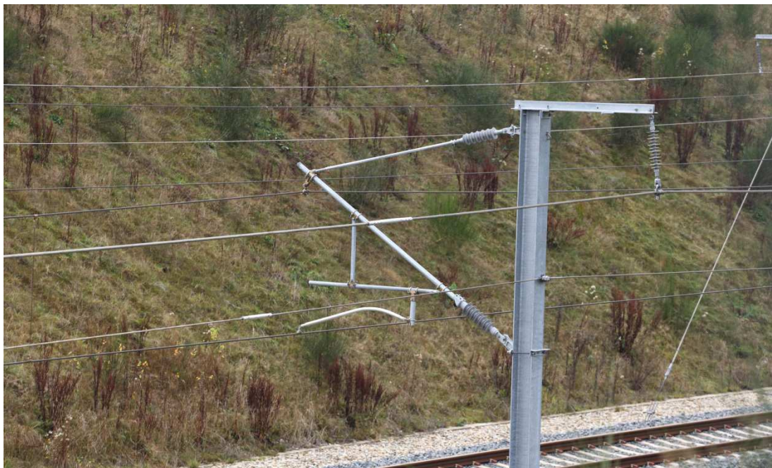
Obrázek 5: Francie – použití konzoly typu „vně“ na LGV Est
