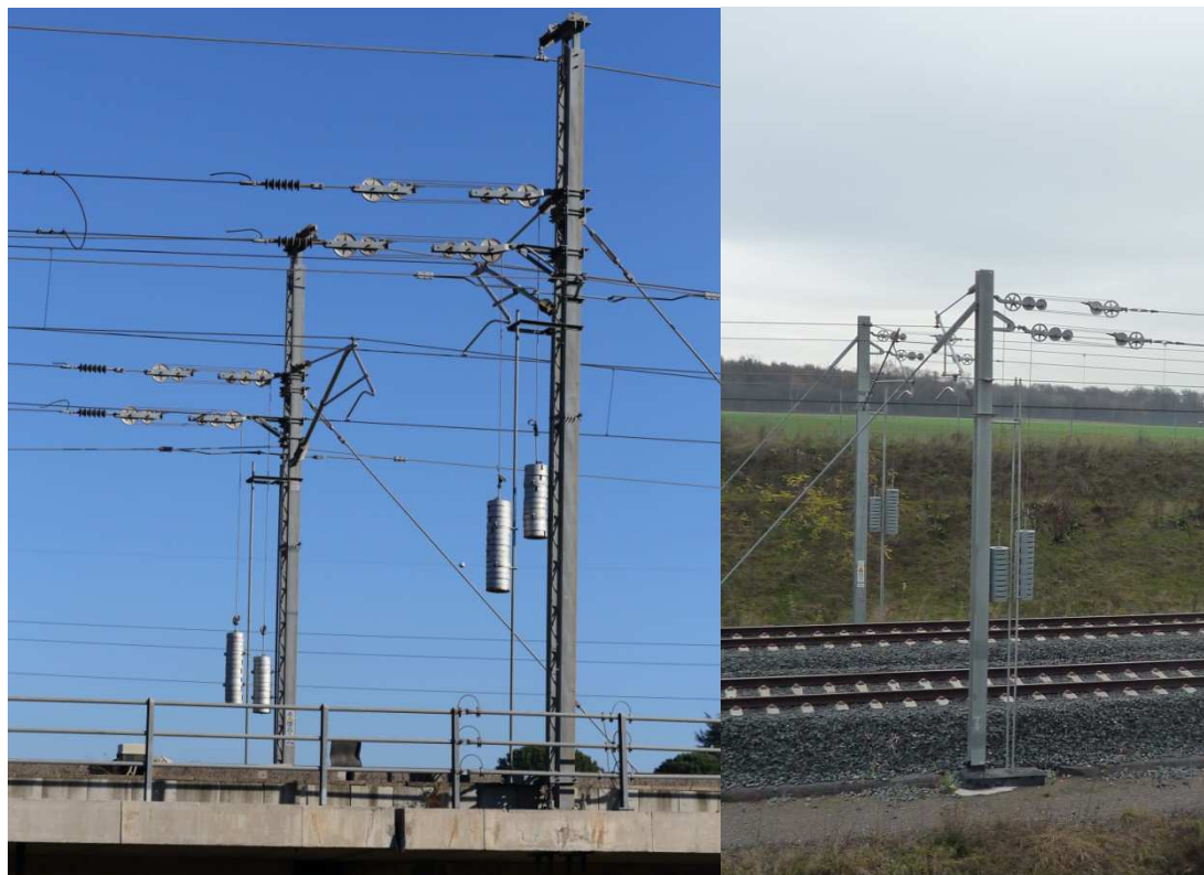
Obrázek 8: Kladkový typ kotvení – Itálie a Francie
